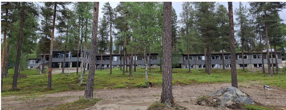
14. ”Rakennuksen arkkitehtuuri näyttäytyy parhaimmillaan lounaasta Jerisjärven suunnasta avautuvissa näkymissä. Julkisivuja hallitsevat järvimaisemaan avautuvat suuret ikkunat. Rinteessä sijaitsevassa rakennuksessa on järven puolella kaksi kerrosta.” Kuvaote rakentamishistoriaselvityksen sivulta 16. © Sweco Finland Oy 2026.
