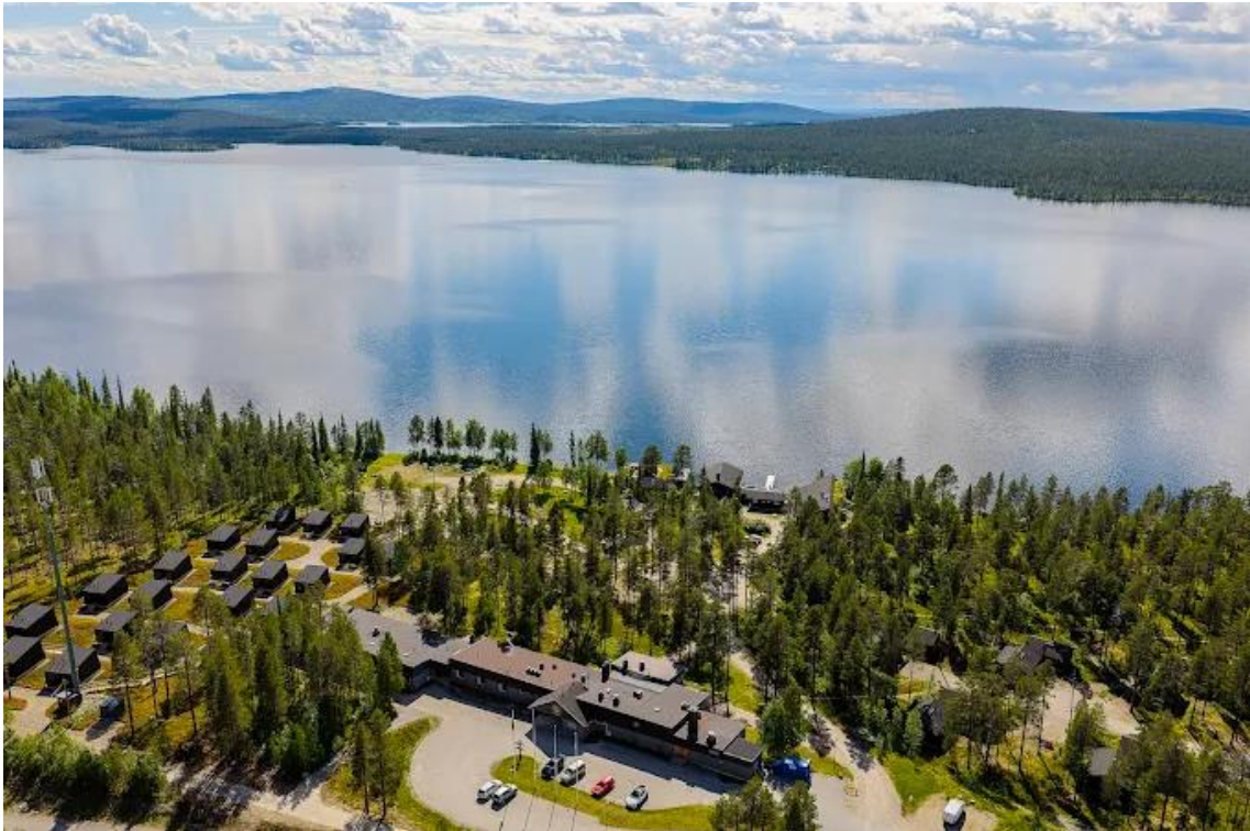
12. Viistokuva suunnittelualueen rakennetusta ympäristöstä. Etualalla on hotellirakennus, jonka vasemmalla puolella on v.2025 rinteeseen toteutetut 20 yksitöismajoitetta. Rannassa on 2000-luvulla toteutettu saunamaailma. Hotellin oikealla puolella sijaitsee kaava-alueen sisään jäävä Koy Jerisrannan vapaa-ajan asuntoalue. © Harriniva Oy 2026.
